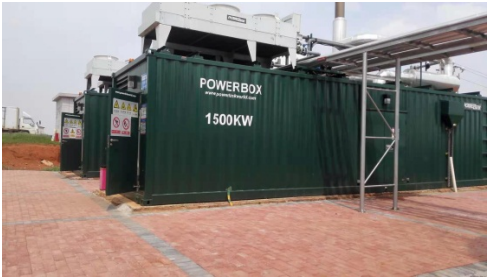
图 2 两台沼气发电机组
